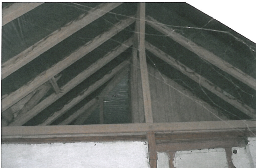
30. Krokwie na rama stolcową posiadają identyczne ślady działania wody.
