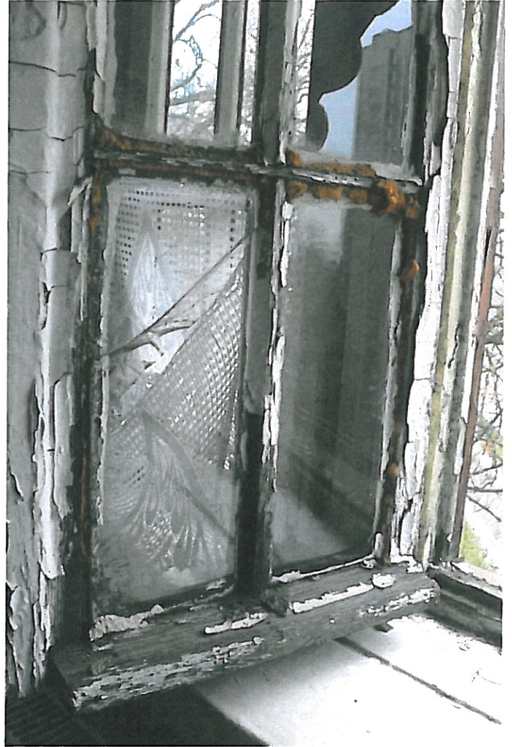
7, 8. Stan techniczny skrzydeł okiennych: wieloletni brak konserwacji, złuszczone farby, ubytki w oszkleniu i okitowaniu, zbutwiałe drzewce ramiaków. Braki w okitowaniu zastąpione pianką montażową o porowatej strukturze przyspieszają proces niszczenia stolarki (okna z połaci zachodniej i północnej).
