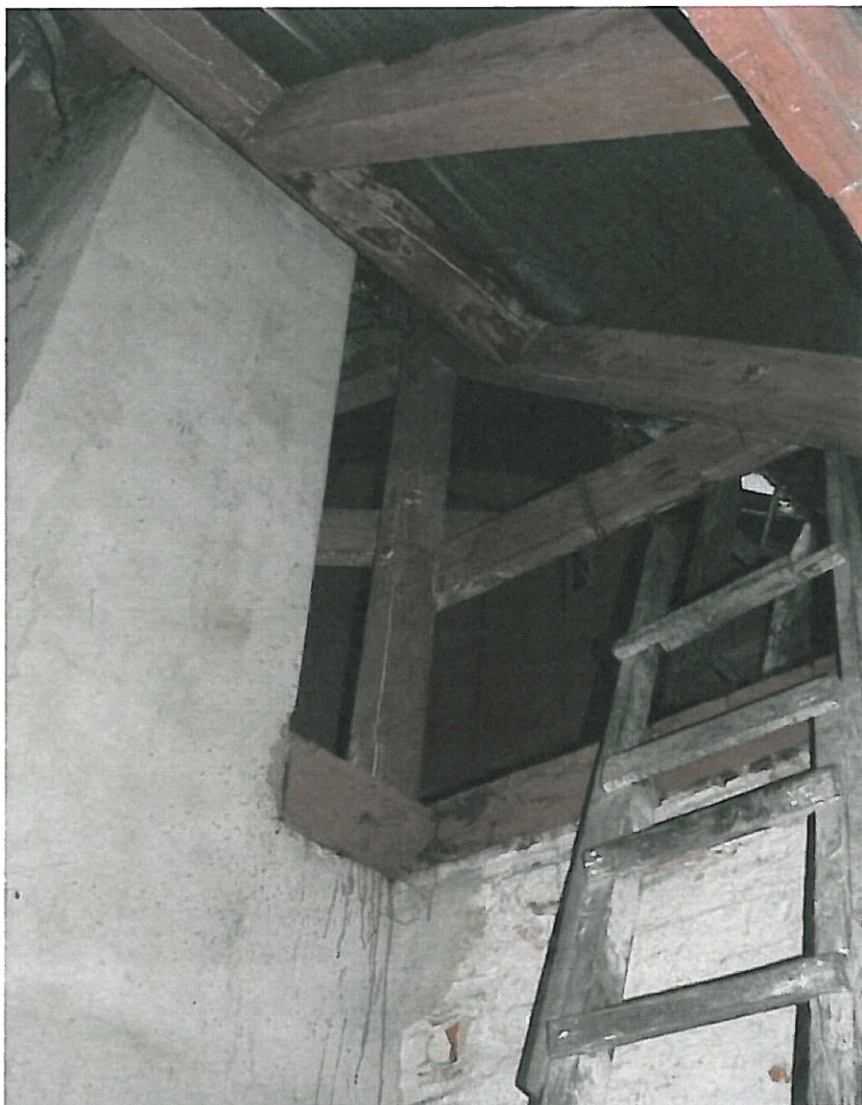
22. Północna część strychu - w górnych partiach wieźby widoczne zacieki. Kominy na poddaszu w stanie dobrym.
