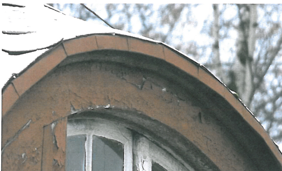
11. Okno jw. - widoczny brak konserwacji, łuszcząca się farba. Jedyne obróbki blacharskie zabezpieczone antykorozyjnie sprostą próbę czasu.
