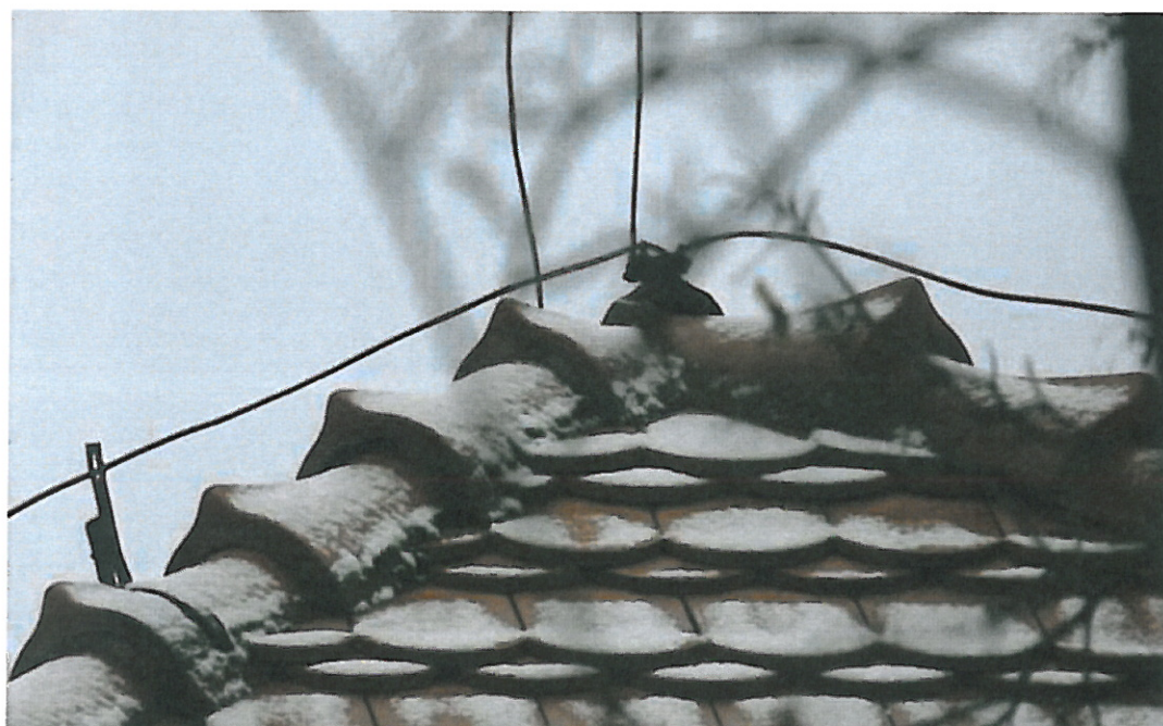
14. Widoczne ubytki w uszczelnieniu gąsiorów narożnych i w kalenicy – dodatkowe miejsce penetrowania wilgoci
