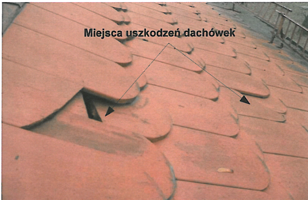
16. Pęknięte dachówki karpiówki układane w koronkę.
