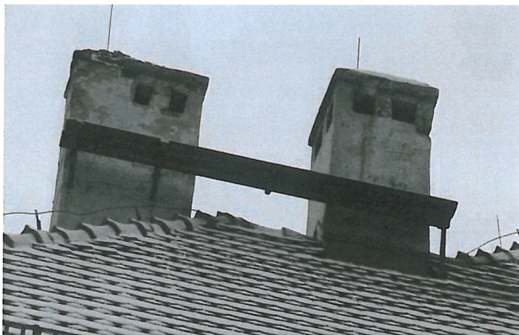
19. Kominy ponad dachem wymagają przemurowania. Wsporniki ław kominarskich wymienić lub zregenerować.
