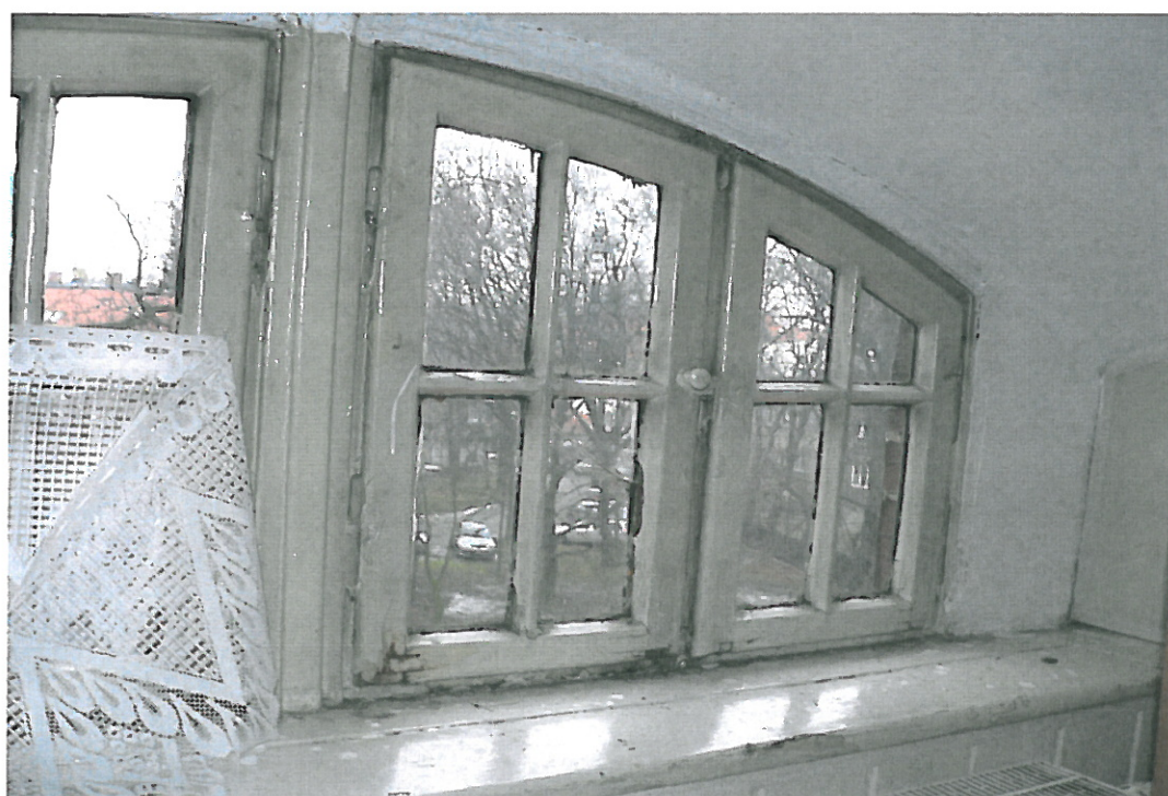
6. Okno po stronie wewnętrznej w lepszym stanie technicznym, jednak skorodowane okucia wskazują na konieczność wymiany okien z uwagi przegnite drzewce skrzydeł.
