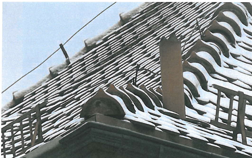
13. Brak kapturka na rurze wywiewnej w narożu południowo – wschodnim.
