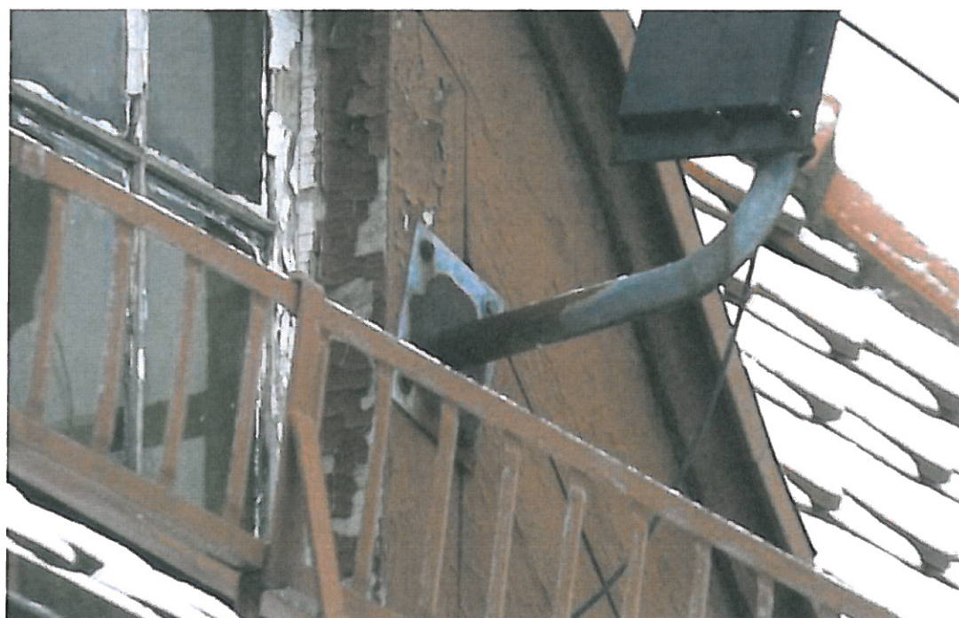
12. Dodatkowe elementy mocowane do drewnianych części wykończenia winny zapewniać odprowadzenie wody opadowej od budynku! Ślady korozji wspornika świadczą o niewłaściwym sposobie zamontowania i sączeniu się wody w stronę elewacji.
