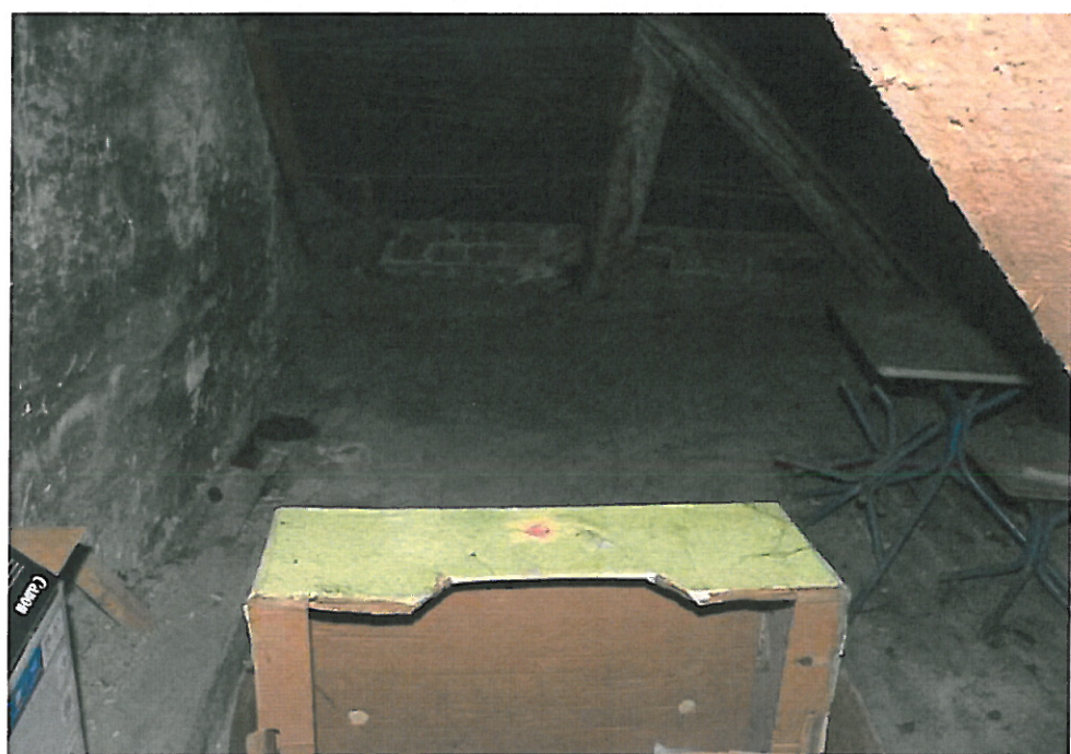
25. Strych w części południowej – drzewce więźby w połaci zachodniej wymagają interwencji.
