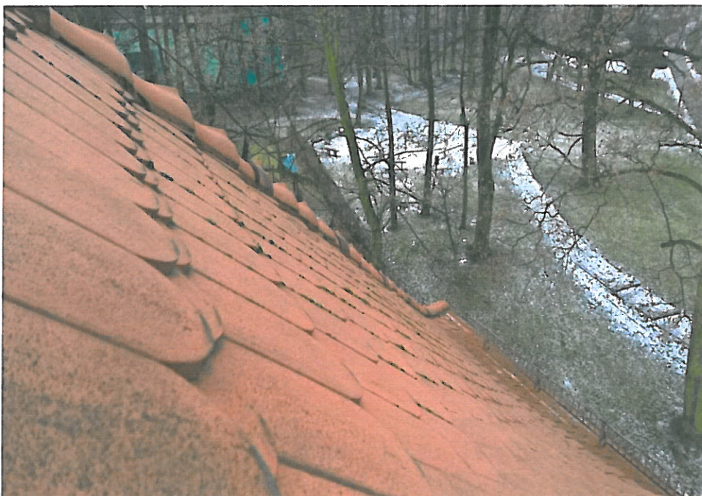
18. W szczelinach między dachówkami widoczny jest wrośnięty mech, który należy z uwagi na trwałość przekrycia usunąć.
