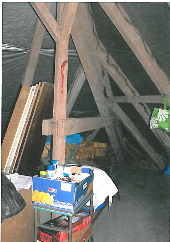
28. Więźba w narożu północno zachodnim: zacieki wskazujące na nieprawidłowości w zakresie infiltracji na poddaszu
