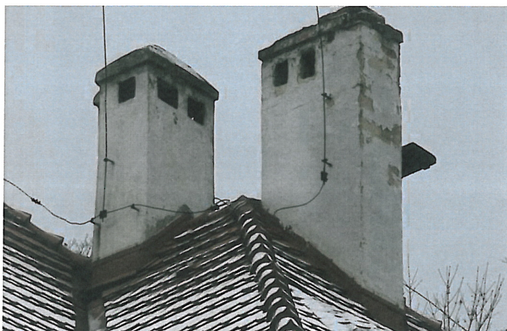
20. Przemurować należy 100% kominów ponad dachem. Odtworzyć czapki kominowe i uzupełnić tynk. Po robotach przeprowadzić odbiór kominarski w celu uzyskania pozwolenia na użytkowanie przewodów.
