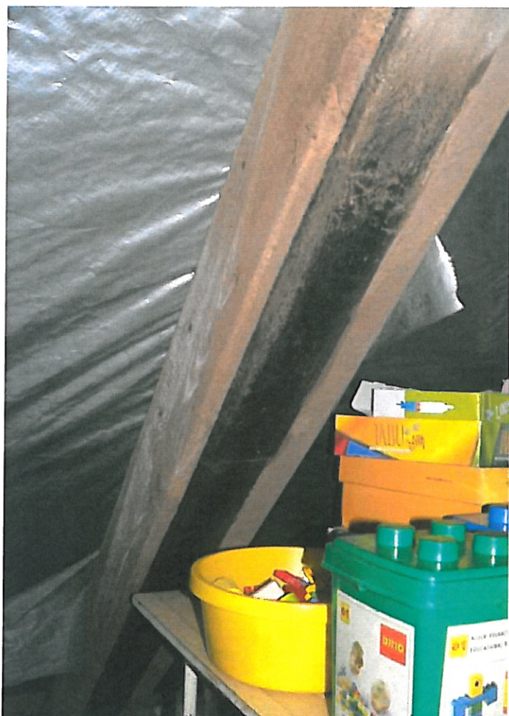
27. Krokiew wzmocniona przez dwustronne nadbicie
