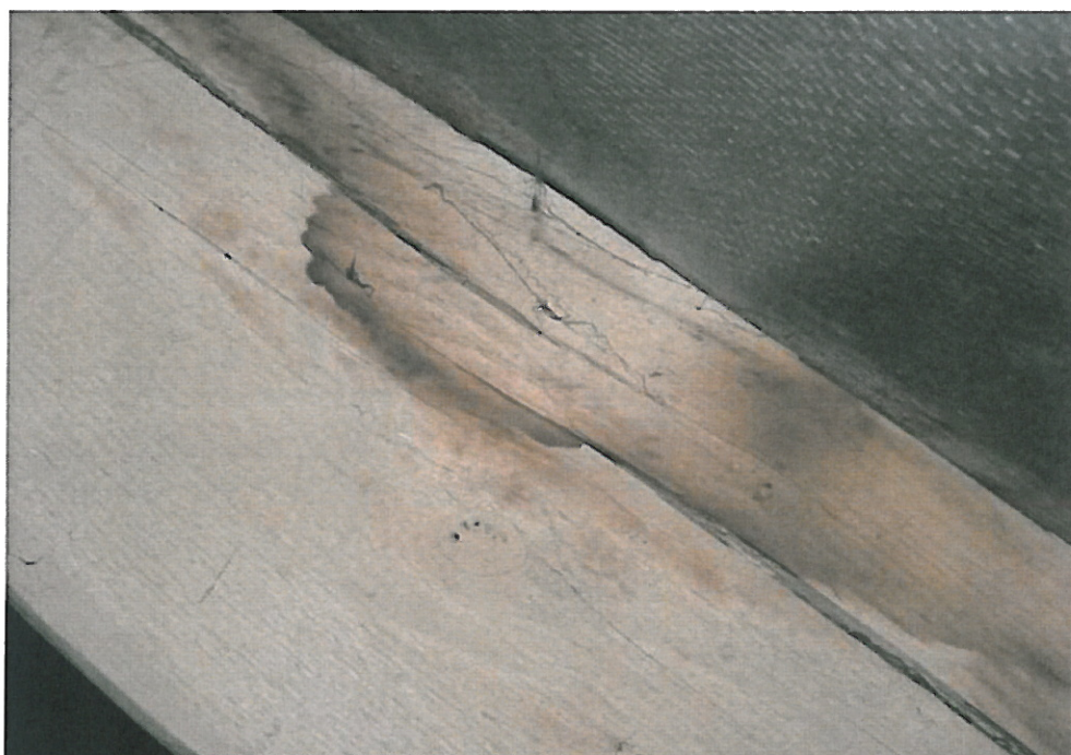
31. Szybka interwencja pozwoli zapobiec dalszej korozji biologicznej drewna bez konieczności wymiany elementów konstrukcyjnych.
