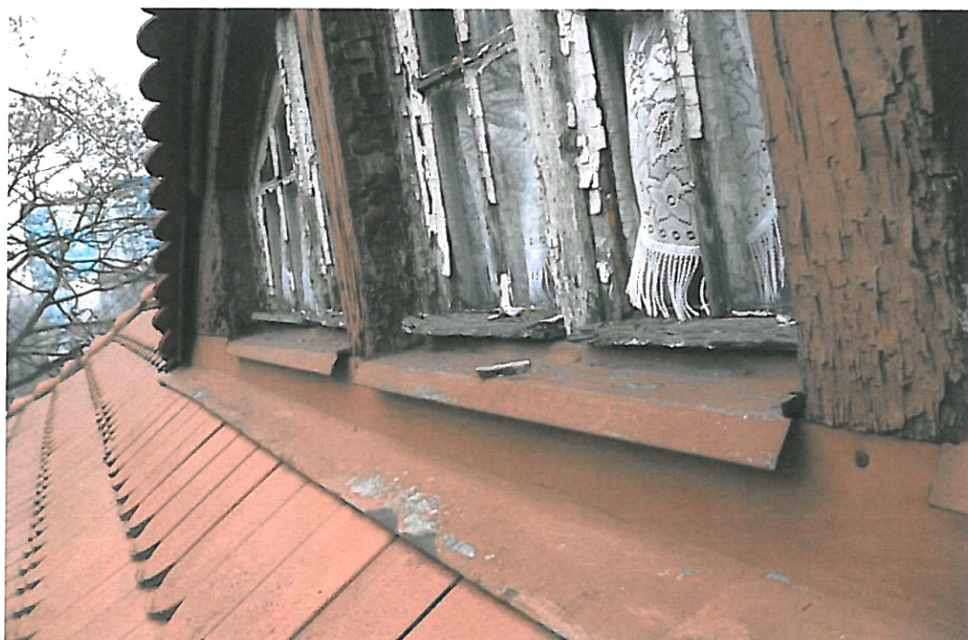
15. Okno w połaci południowej w identycznym stanie technicznym jak pozostała stolarka na poddaszu. Istniejące obróbki blacharskie skutecznie zabezpieczają potencjalne miejsca przeciekania wody deszczowej do budynku.
