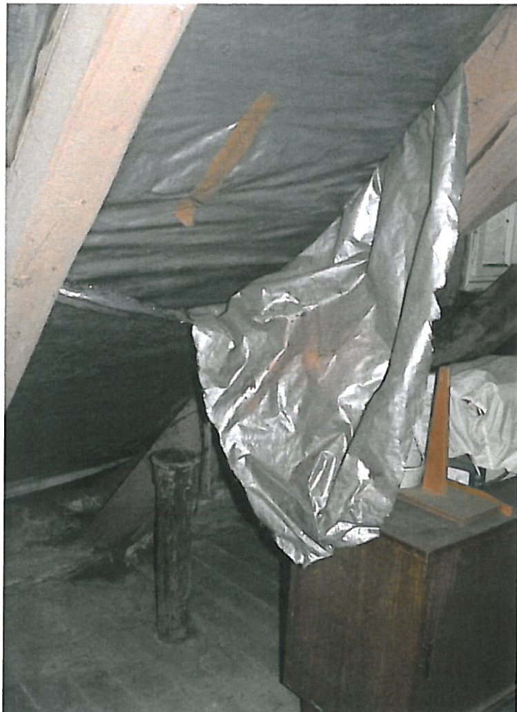
33. Widoczne uszkodzenie folii wiatroszczelnej. Rurę Kanalizacyjną należy wyprowadzić ponad dach lub szczelnie zamknąć, jeżeli dotyczy ona nieczynnej części kanalizacji
