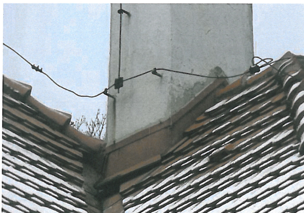
21. Starannie wykonać obróbki blacharskie kominów ze szczególnym wskazaniem na wspólne krawędzie połaci dachowych, kosze zlewowe itp..
