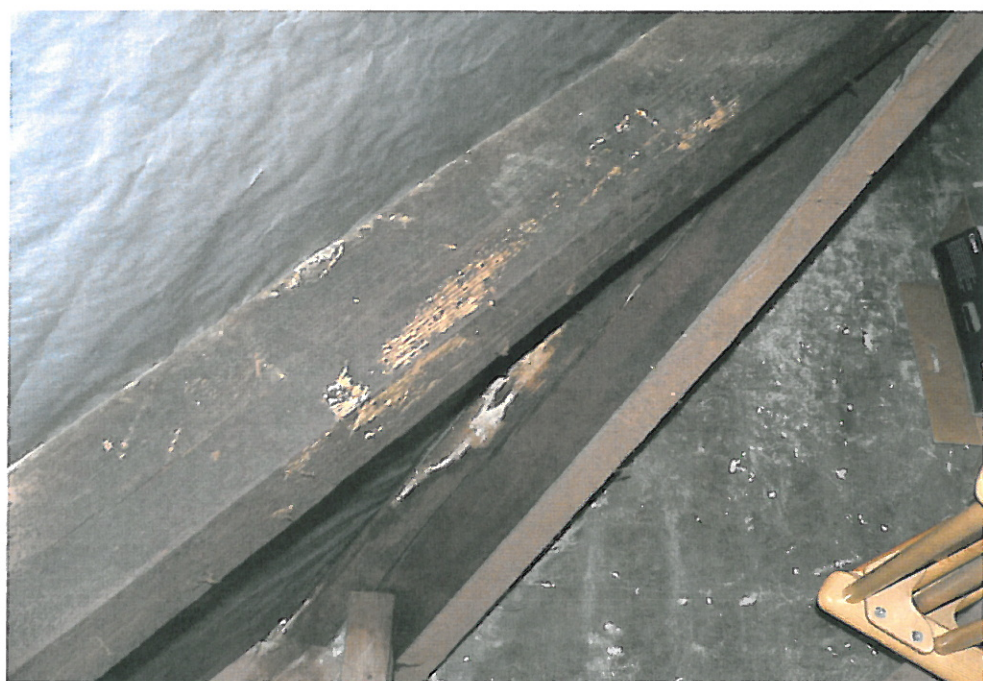
26. Wilgoć powoduje łuszczenie się farby oraz tworzy naloty, które łatwo można usunąć np. ostrzem noża.
