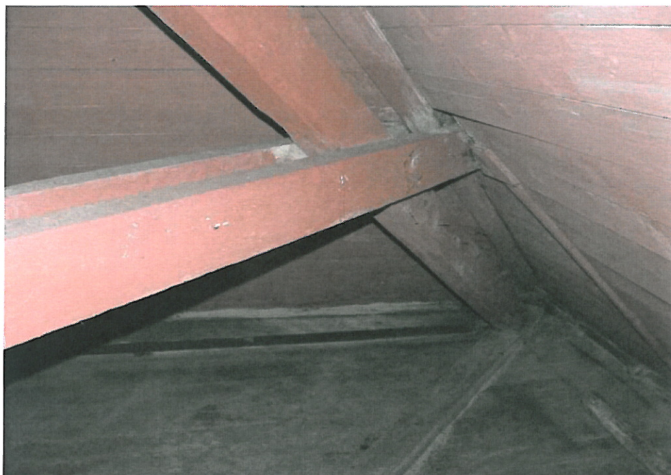
24. Na trudne warunki temperaturowo – wilgotnościowe wskazuje łuszcząca się farba w dolnej części krokwi narożnej
