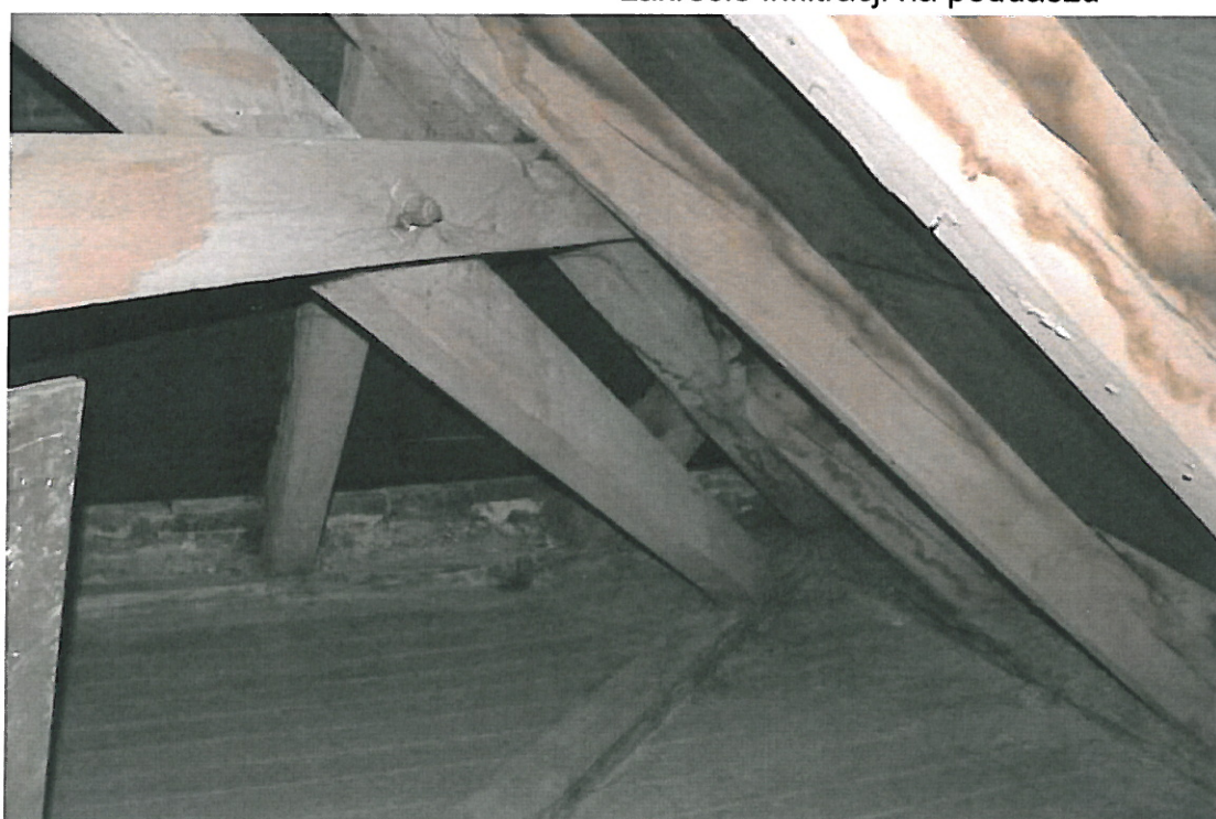
29. Więźba w narożu północno wschodnim zacieki widoczne na krokwiach. Sucha podłoga z desek świadczy o braku przecieków zalewających pomieszczenia.
