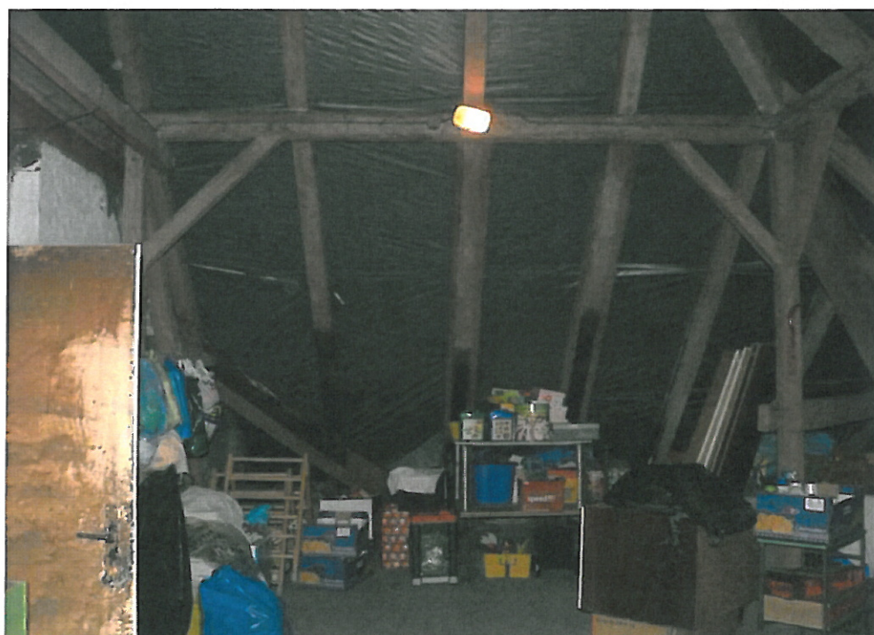
32. W południowej części strychu, krokwie były już impregnowane – ciemne pasy widoczne na krokwiach.
