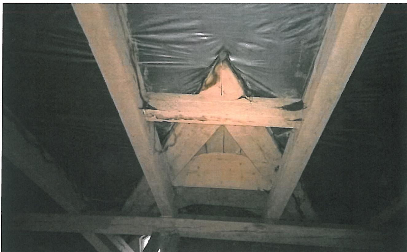
34. Deskowanie wolego oka. Krajzyny w dobrym stanie. Pełna ocena stanu deskowania możliwa dopiero w czasie przekładki dachu. W razie potrzeby wymienić deski na nowe w niezbędnym zakresie.
