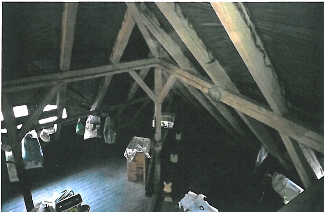
34. Zacieki na krokwiach powstałe w wyniku kondensacji pary wodnej na folii dachowej oraz przedostawania się wody przez folię wskutek niewłaściwej wentylacji przestrzeni pod pokryciem z dachówki.
