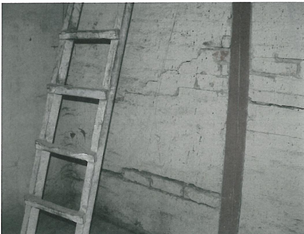
23. Pęknięta ścianka pomiędzy pomieszczeniami w północnej części strychu. Sugeruje się rozbiórkę ścianki murowanej i zastąpienie jej lekkim przepierzeniem, z wypełnieniem z wełny mineralnej.
