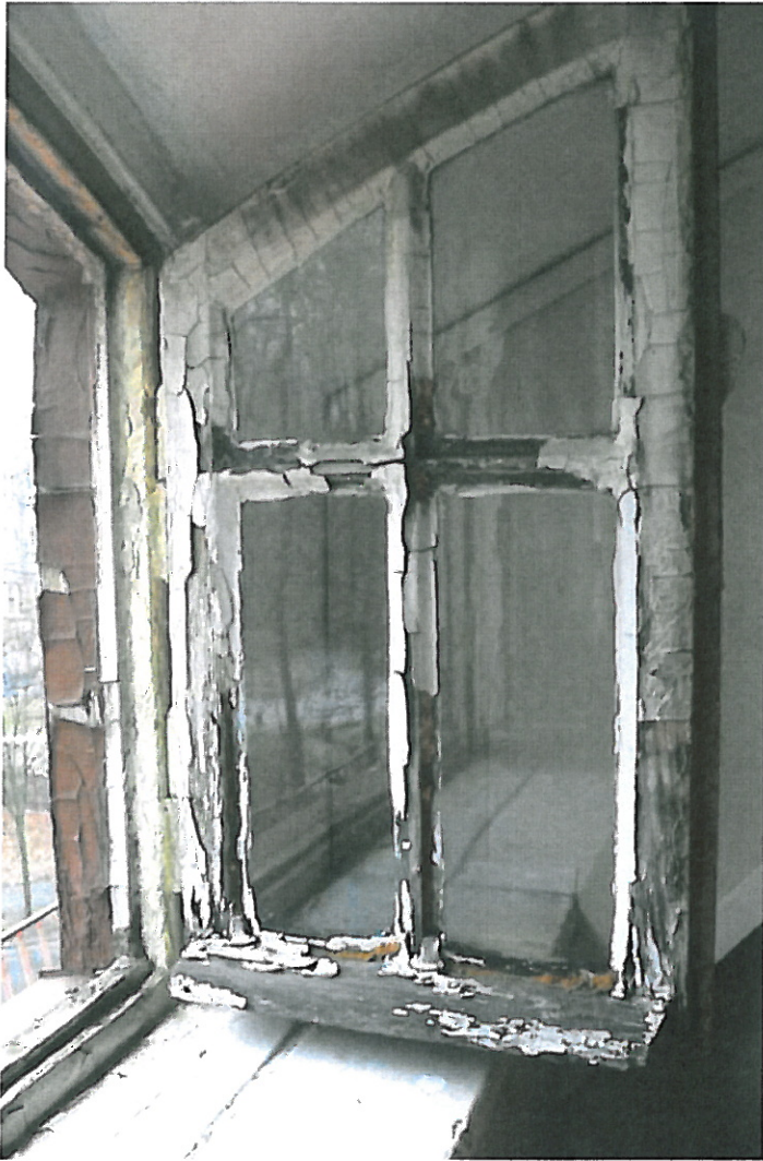
7, 8. Stan techniczny skrzydeł okiennych: wieloletni brak konserwacji, złuszczone farby, ubytki w oszkleniu i okitowaniu, zbutwiałe drzewce ramiaków. Braki w okitowaniu zastąpione pianką montażową o porowatej strukturze przyspieszają proces niszczenia stolarki (okna z połaci zachodniej i północnej).
