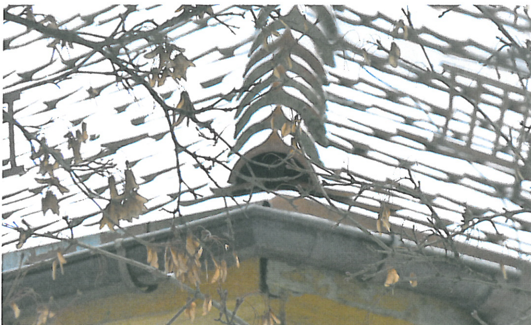
3. Brak dekla w ostatnim gąsiorze w południowo – zachodnim narożu.
