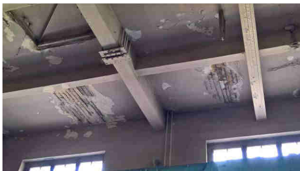
Widok stropu 18.05.2017r – korozja płyt
