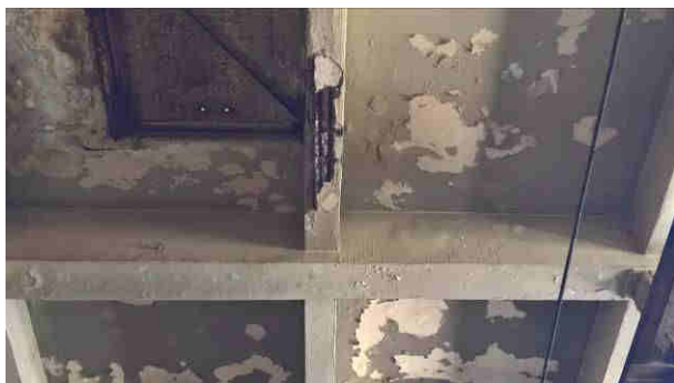
Widok stropu 18.05.2017r – korozja żebra
