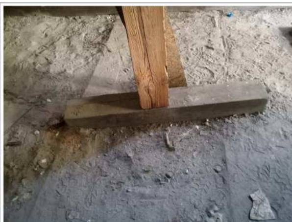
Fotografia 2: Słupki więźby podparte za pomocą wymianów belkami więźby
