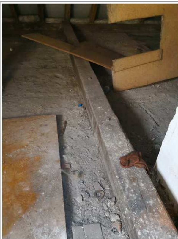
Fotografia 1: Nadciąg do którego podwieszone są belki więźby dachowej
