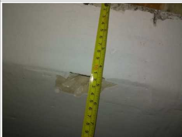
Fotografia 5: Pomiar szerokości stopki belki stalowej
