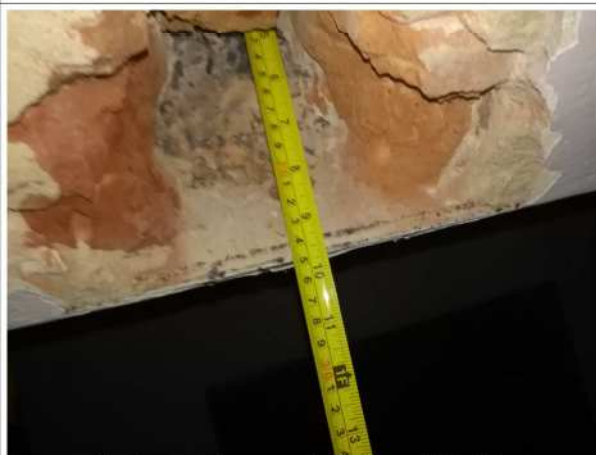
Fotografia 6: Pomiar wysokości stopki belki stalowej (od spodu belki do spodu półki górnej)
