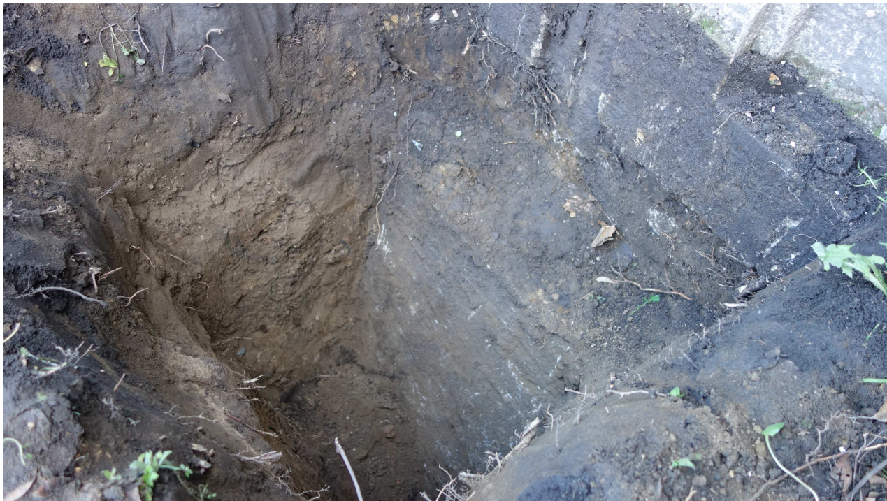
Fot.2. Odkrywka nr 1 – widok monolitycznej ławy fundamentowej z odsadzką
