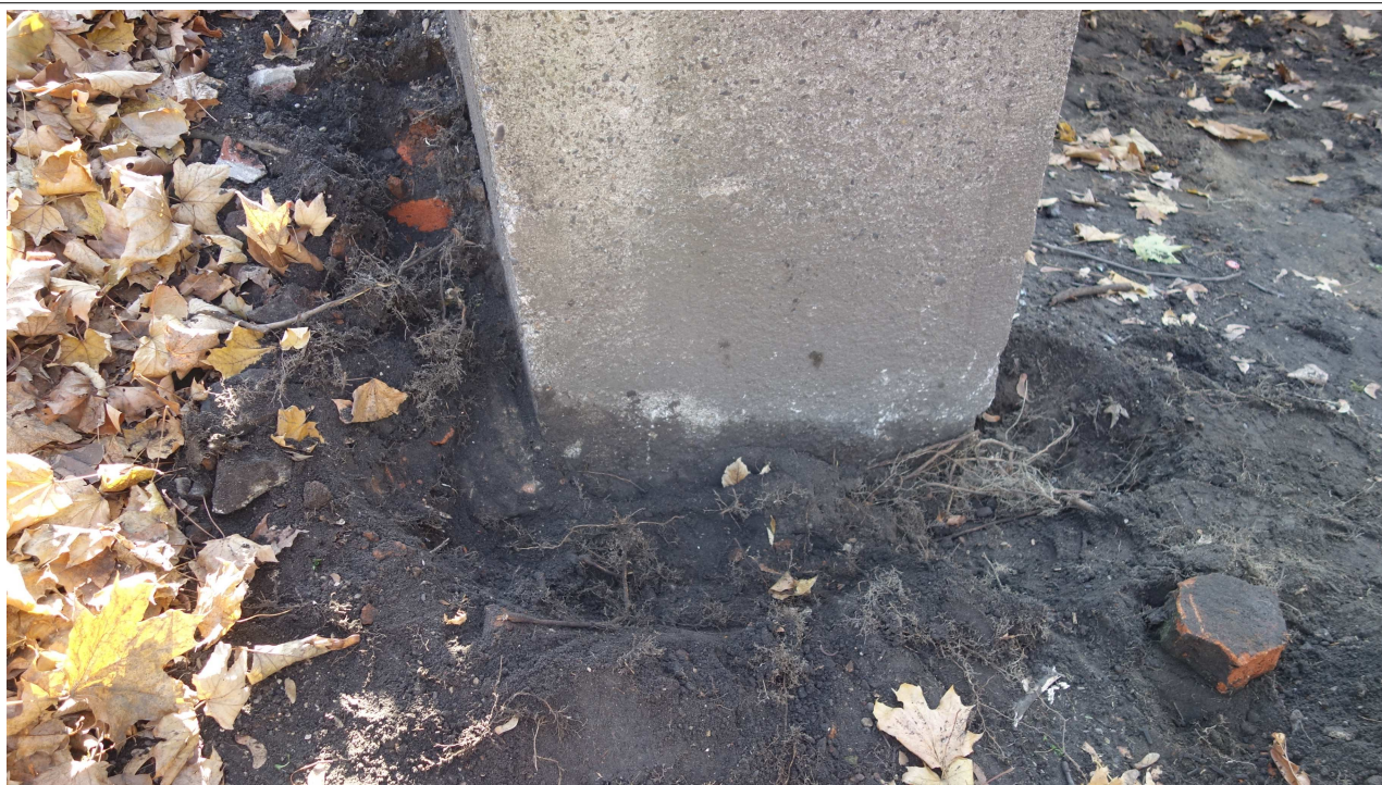
Fot.18. Północne zakończenie muru – widoczna obmurówka z cegieł od strony wschodniej i północnej
