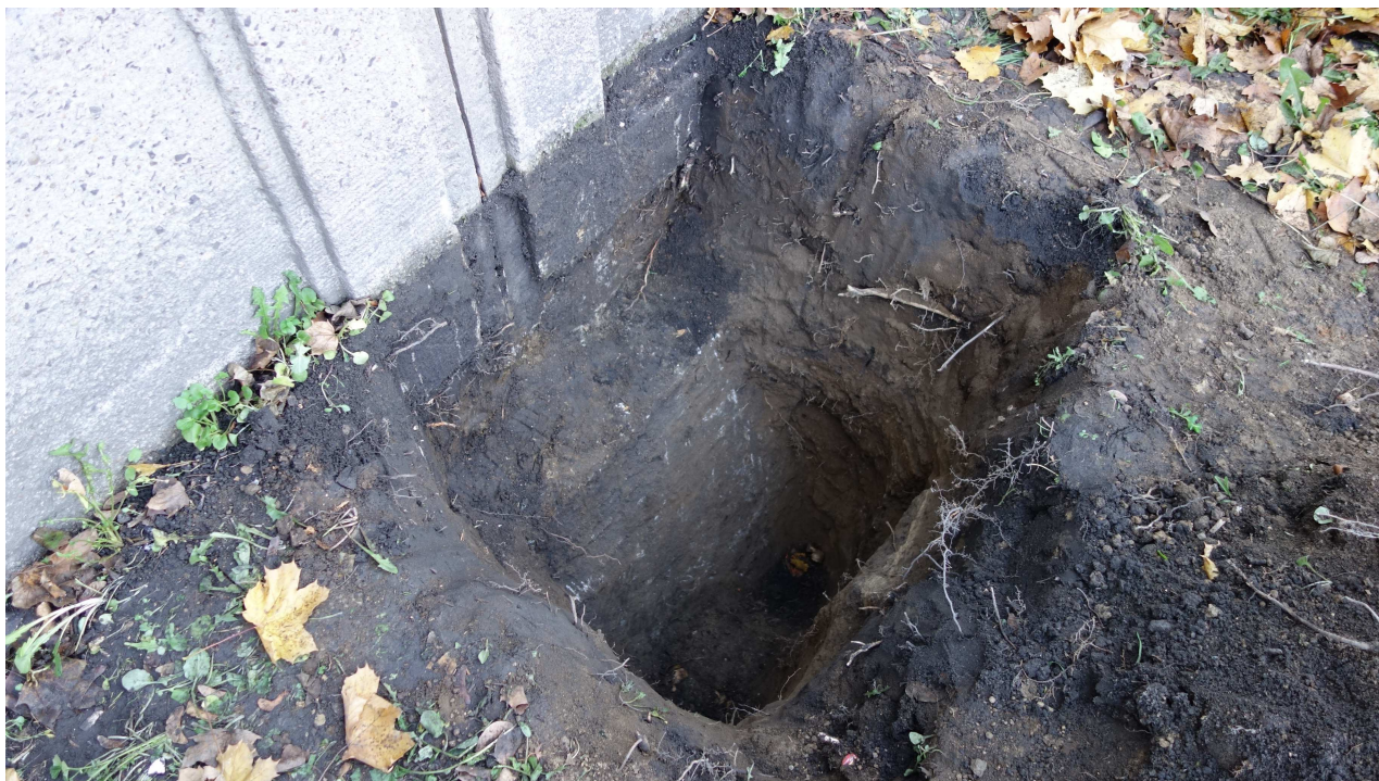
Fot.3. Odkrywka nr 1 – widoczna wysokość zalegania gruntu oraz ukośny kształt ławy fundamentowej
