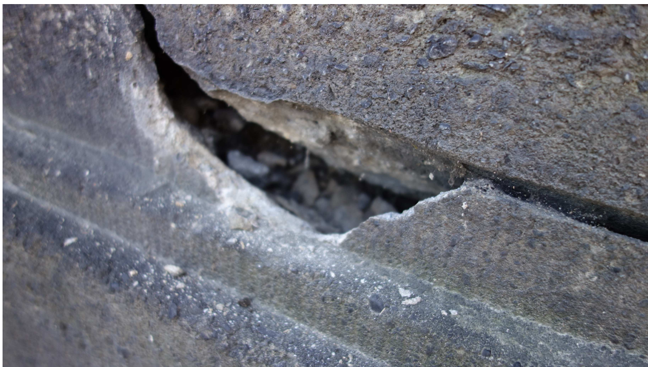
Fot.7. Schody boczne północne – widoczna wypłukana pustka w pęknięciu balustrady
