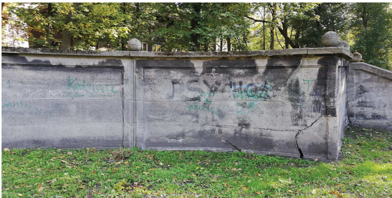
Fot.22. Spękany narożnik muru w części południowej
