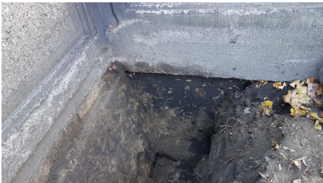
Fot.13. Odkrywka nr 2 – widoczne połączenie balustrady schodów północnych i muru oporowego
