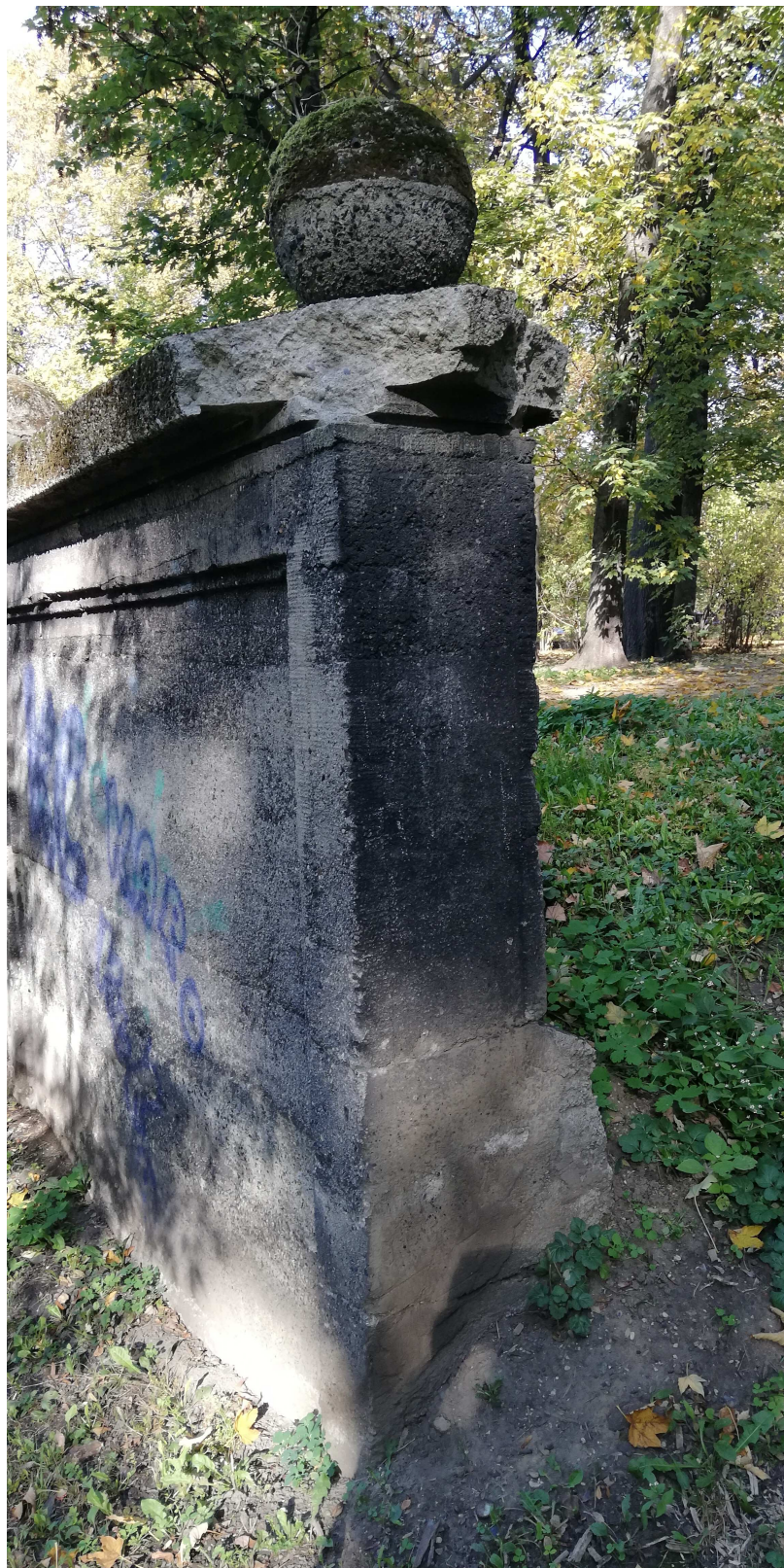
Fot.20. Zakończenie muru oporowego od strony południowej. Widoczne uszkodzenia nakrywy
