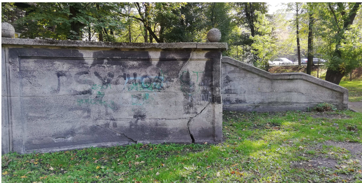
Fot.15. Schody boczne południowe. Widok na zniszczony narożnik muru w kierunku południowym
