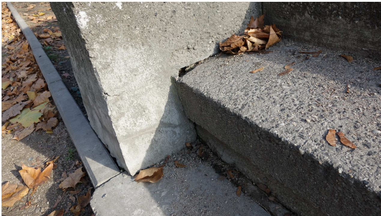
Fot.8. Schody boczne północne – szczelina w miejscu łączenia bloku stopnia i balustrady
