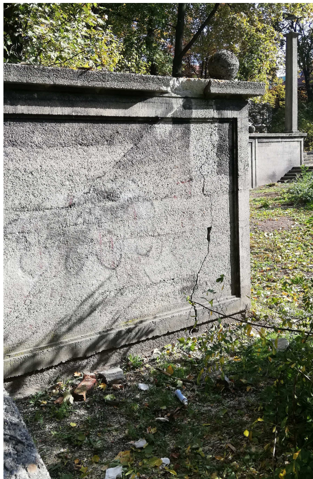
Fot.12. Widok na pęknięty narożnik północny muru (element C-D wg dok. rysunkowej)
