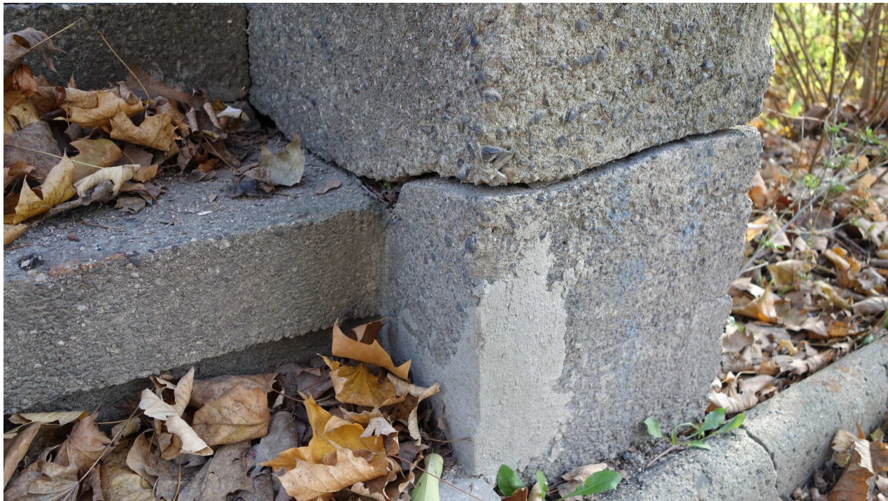
Fot.10. Schody boczne północne – widoczne pęknięcie w miejscu osadzenia stopnia w balustradzie
