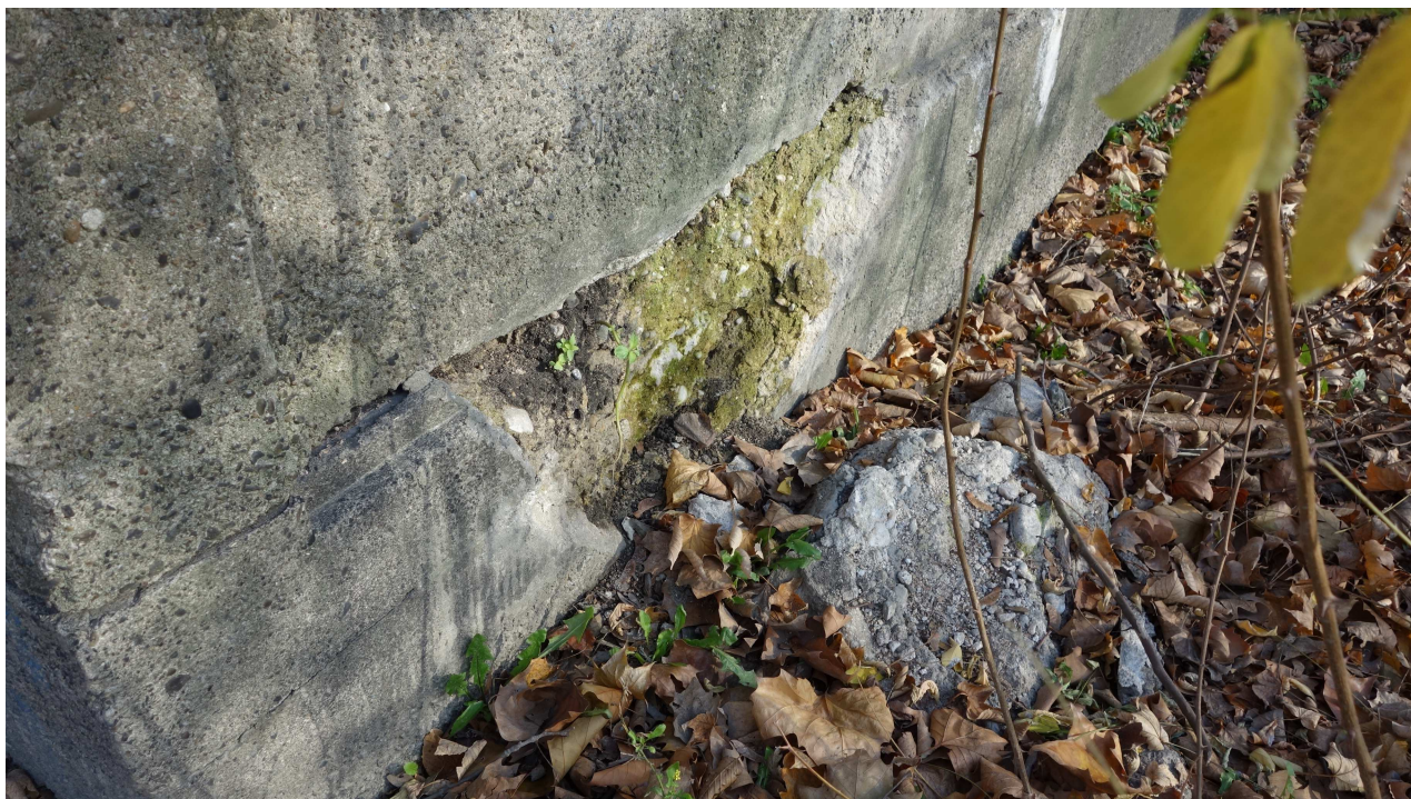
Fot.11. Schody boczne północne, balustrada – widoczna dwuwarstwowa struktura elementu – drobnoziarnista dekoracyjna warstwa zewnętrzna i gruboziarnisty betonowy rdzeń
