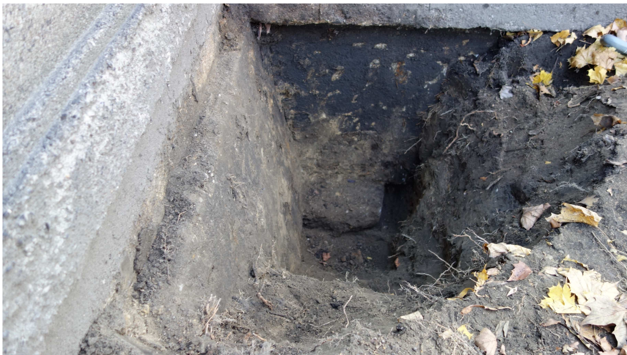
Fot.15. Odkrywka nr 2 – widoczna odsadzka i ukośna łąwa betonowa muru oraz podcięcie i prosta ściana ławy fundamentowej balustrady
