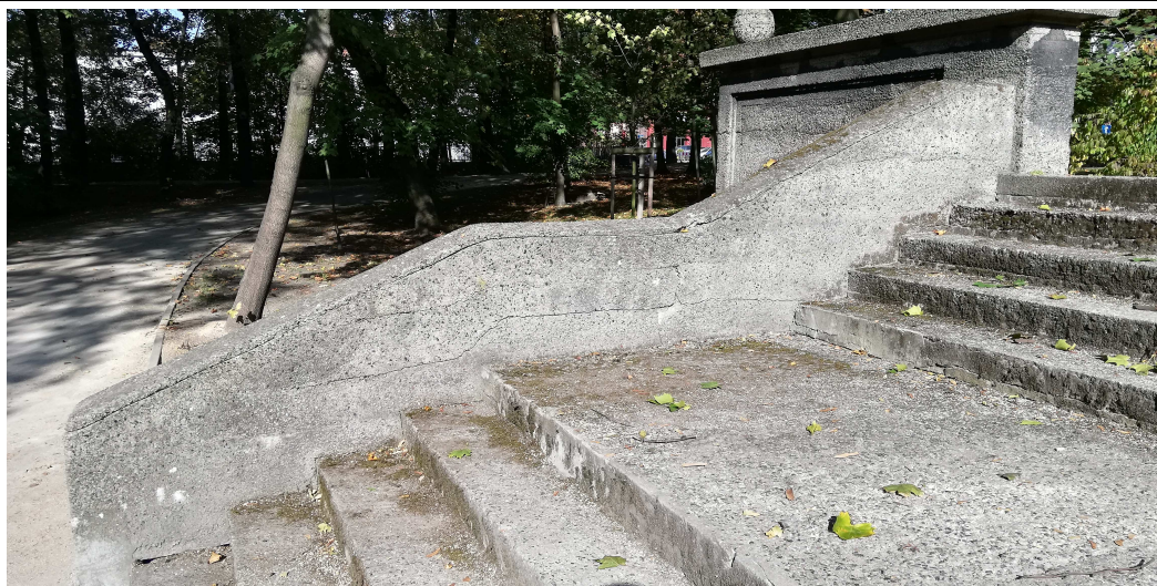
Fot.13. Schody północne - widok na balustradę. Widoczne zarysowania i spękania balustrady
