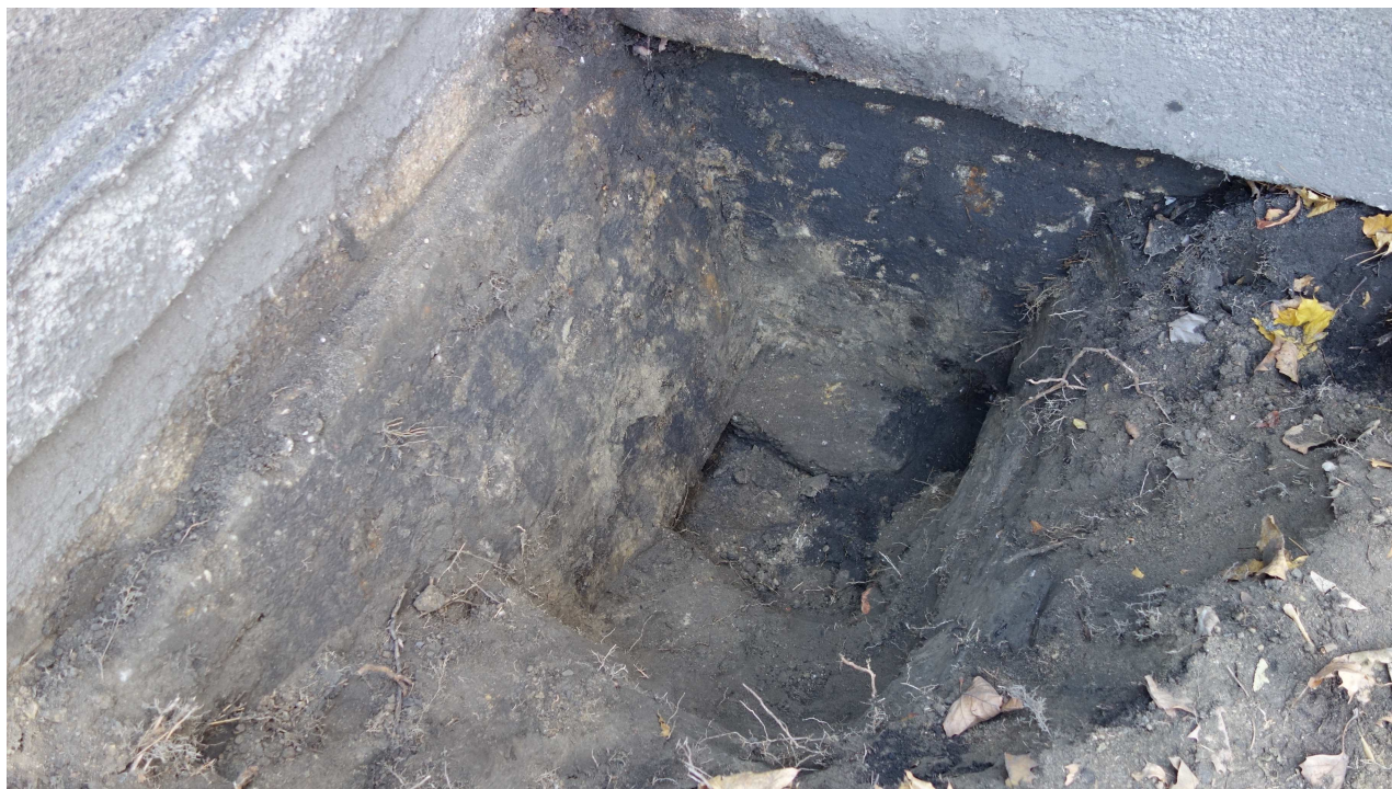
Fot.12. Odkrywka nr 2 – ława fundamentowa na połączeniu balustrady schodów północnych i muru oporowego
