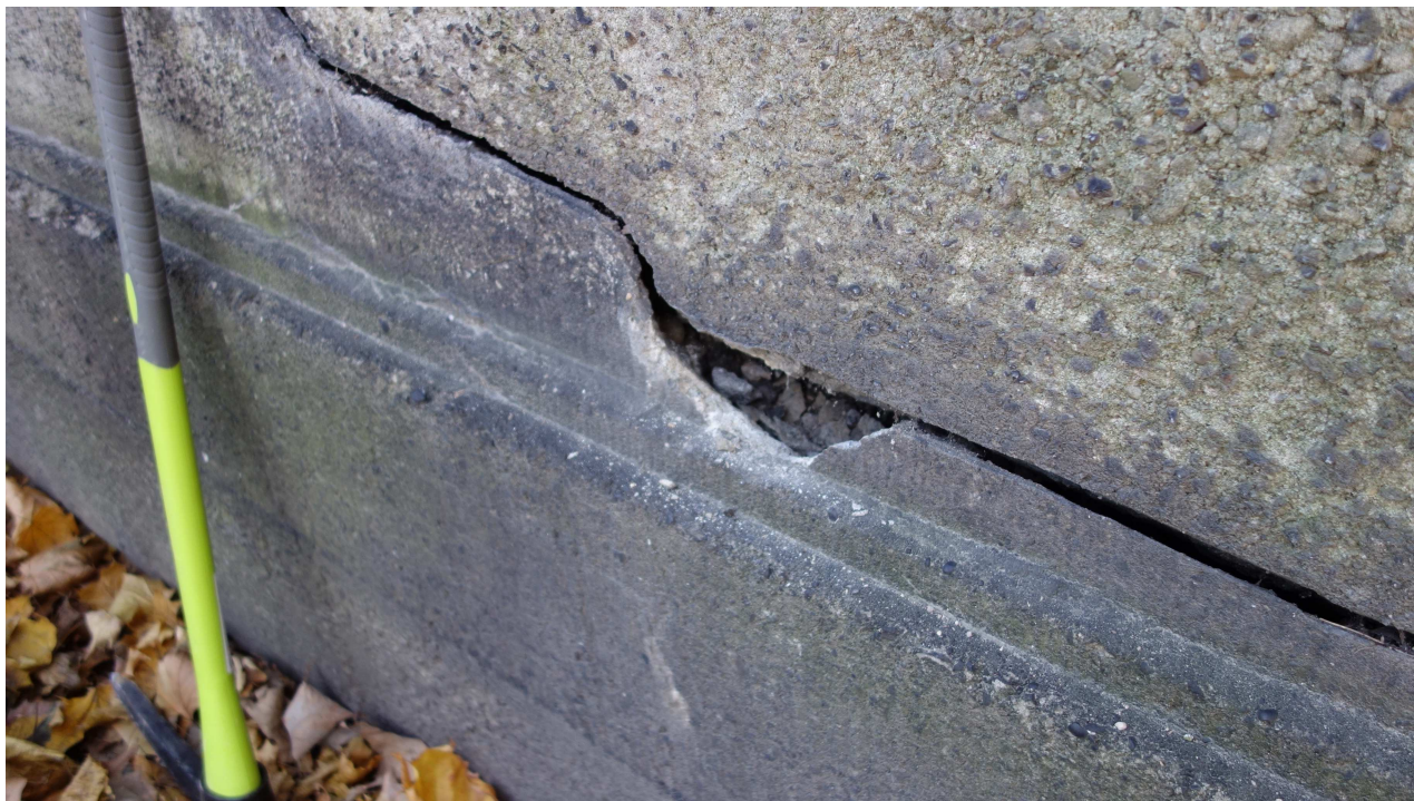
Fot.6. Schody boczne północne – widoczne pęknięcie balustrady schodów
