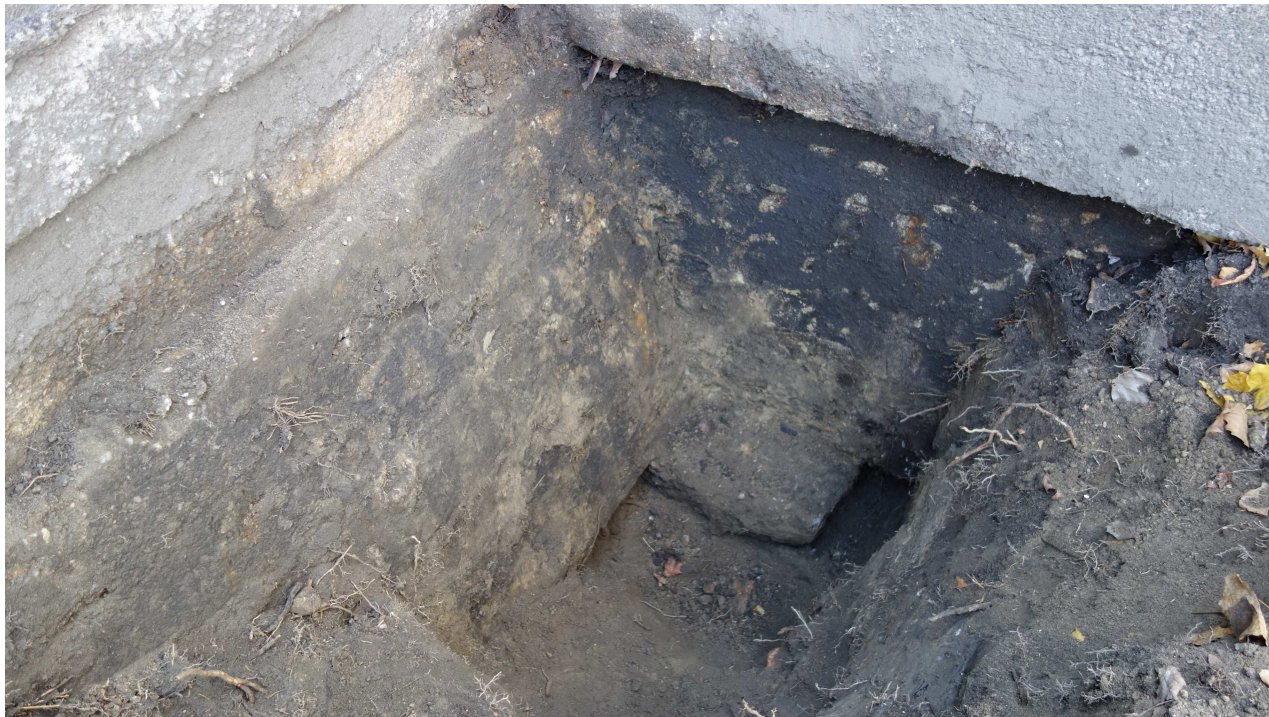
Fot.14. Odkrywka nr 2 – widoczny betonowy blok poniżej łączenia ław fundamentowych muru i balustrady
