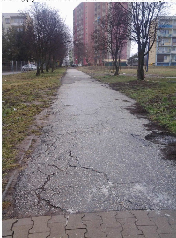
Fot. Widok 4 na zniszczony chodnik przeznaczony do frazowania i wyłożenia nowego asfaltu.
