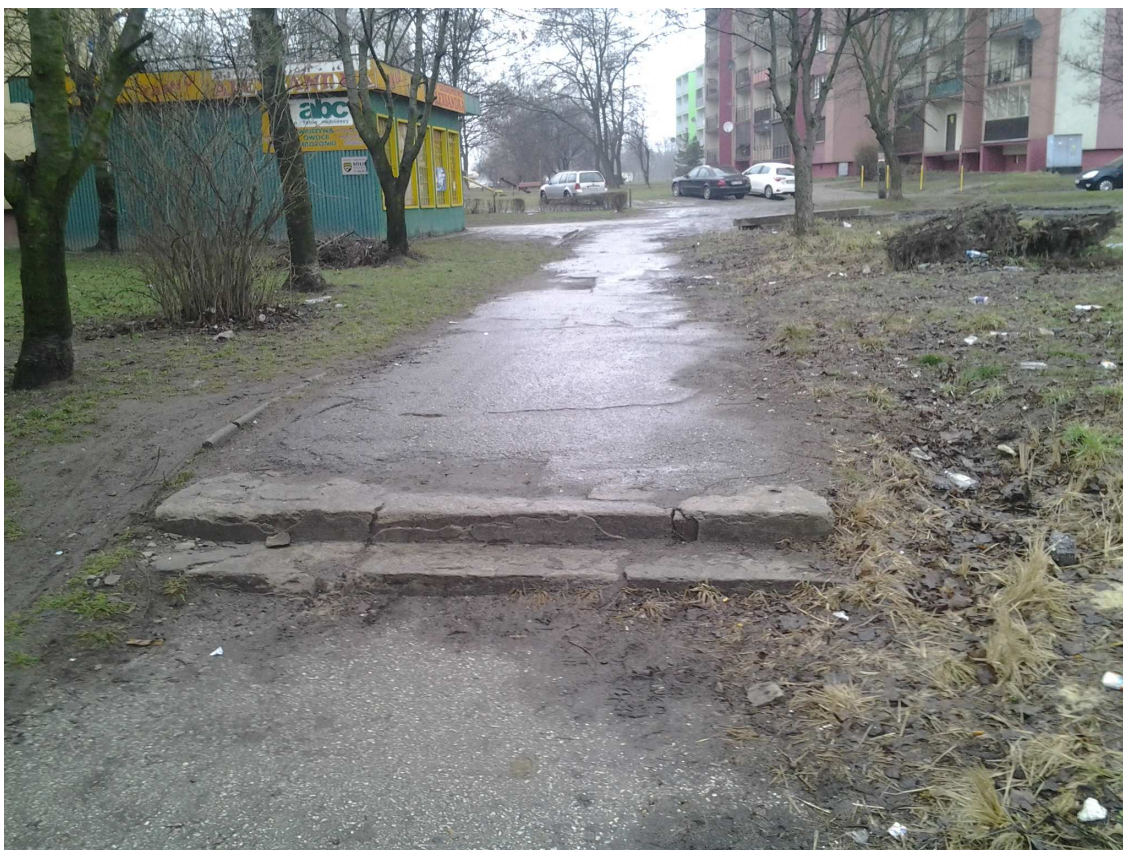
Fot. Widok 5 na rozbiórkę elementów betonowych i wykonania niwelacji terenu i chodnika aby nie było 2 stopni schodowych. Na tym odcinku nawierzchnia chodnika będzie całkowicie rozebrana.
