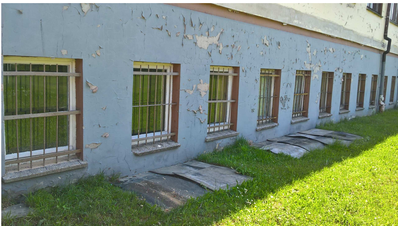
Foto.6. Elewacja tylna – fragment z doświetlaczami okien piwnicznych do odtworzenia.
