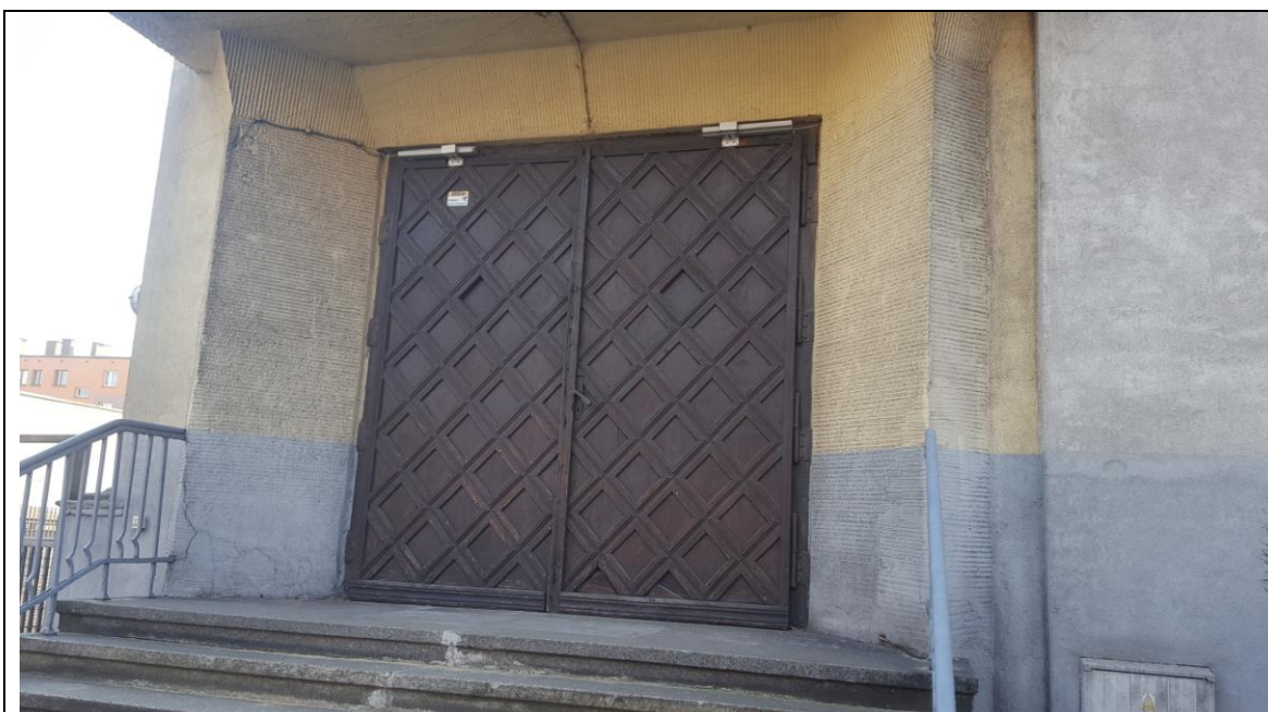
Drzwi D2 260/ 275 cm , widok wewnątrz budynku
