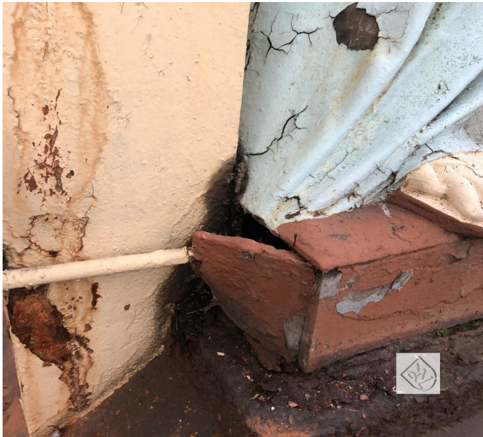
Figura Matki Boskiej, obejma mocująca - stan zachowania
