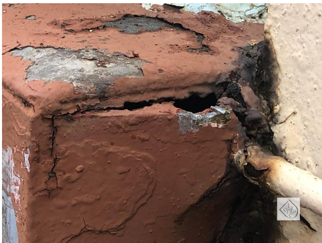
Figura Matki Boskiej, obejma mocująca - stan zachowania
