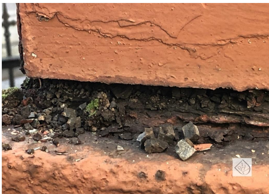
Figura Matki Boskiej, styk z cokołem, stan zachowania
