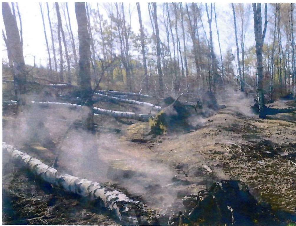
Fot. 6-8: Obszar „B” – wywroty drzew spowodowane rozwijającymi się zjawiskami termicznymi we wnętrzu nasypu
