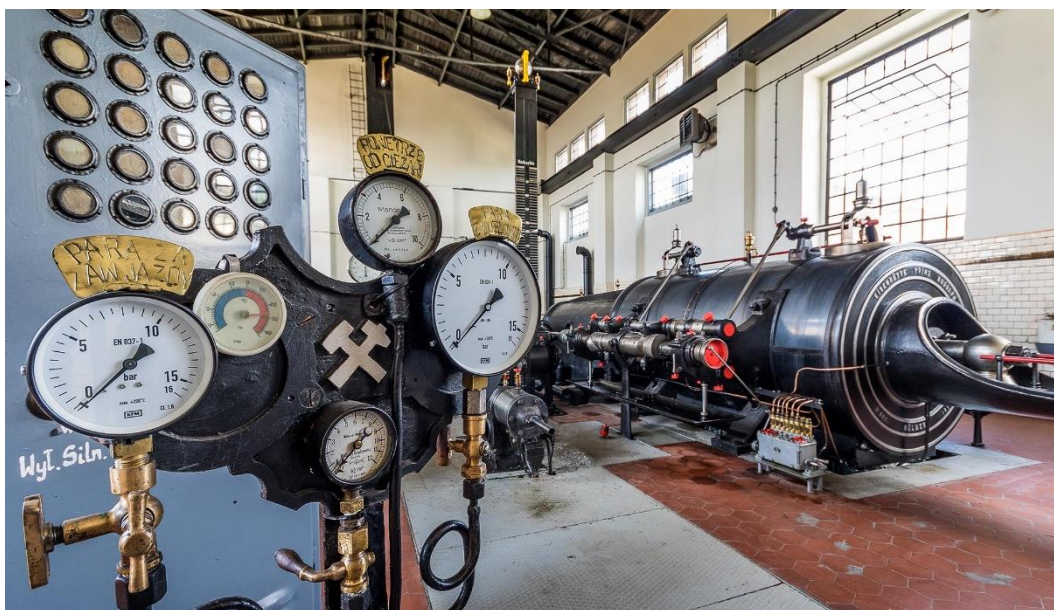
Fotografia. Działająca parowa maszyna wyciągowa z 1915 r.
